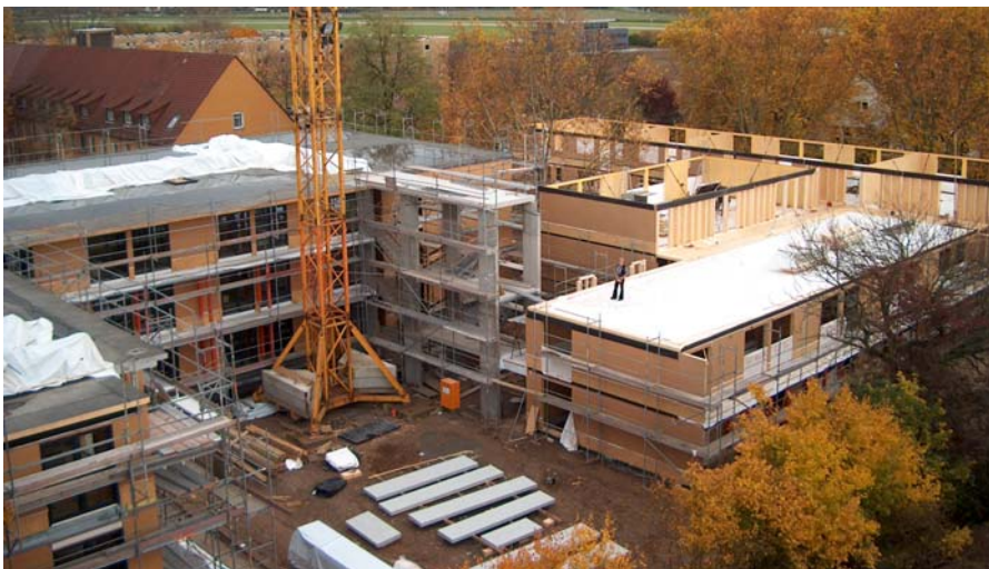
(Bild 7) Der zentrale Treppenhausturm aus Stahlbeton verbindet die beiden Brandabschnitte „Haus I“ und „Haus II“ wie ein Scharnier. Das Studentenwohnheim konnte nach nur zehnwöchiger Bauzeit bereits Richtfest feiern.
