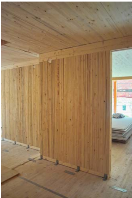
(Bild 6) Für die tragenden Innenwände wurden gebozte Brettstapel-Elemente verwendet.
