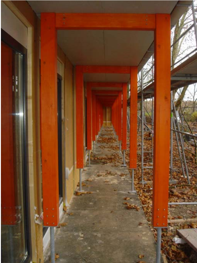
(Bild 10) Die Balkonplatten aus Brettstapel-Elementen werden von Holzrahmenkonstruktionen getragen.
