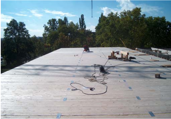
(Bild 5) Stahlaschen verbinden die Deckenelemente zu einer Deckenscheibe.
