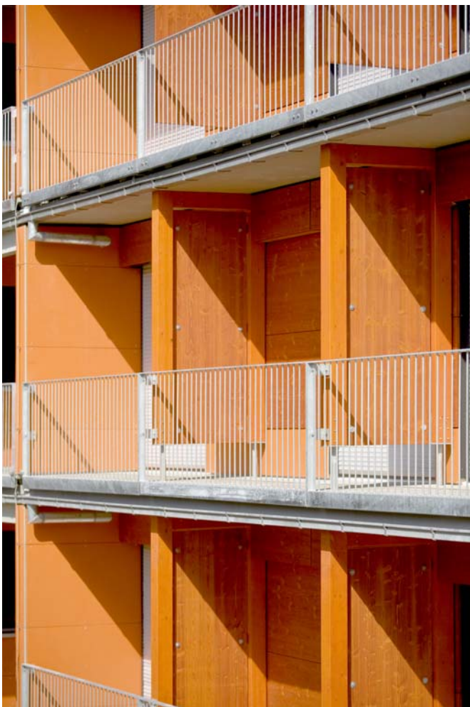
(Bild 11) Die Holzrahmen wurden mit Holztafeln geschlossen, so dass sie als Sichtschutz fungieren und damit die Privatsphäre der Appartements schützen.
