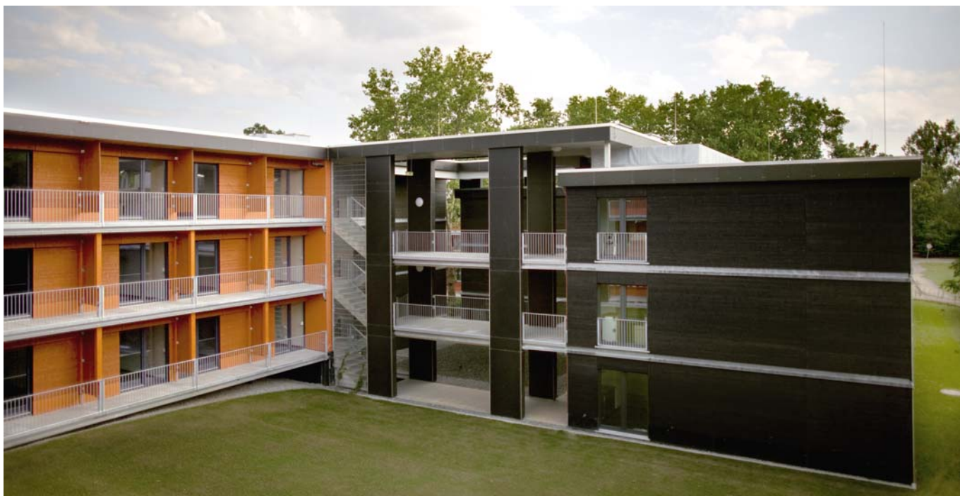
(Bild 8) Blick in den Innenhof von Haus I auf die Stahlbetonkonstruktion mit integriertem Treppenhaus und den Verbindungsbrücken.
